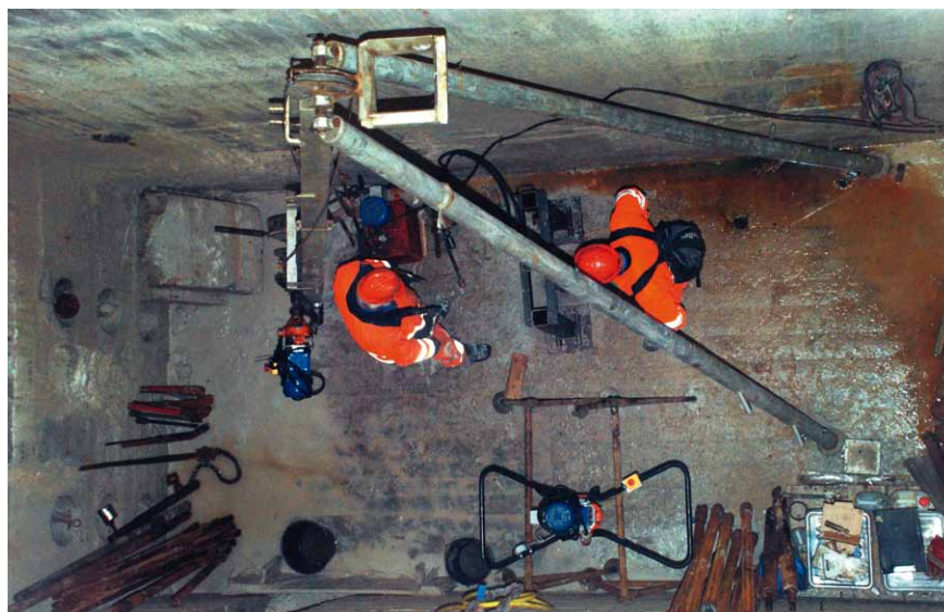
Der bores under snævre forhold 28,5 meter under havets overflade.
